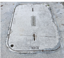
Caja de derivación o Caja de empalme
