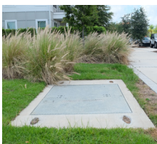
Caja de derivación con puerta de torsión
